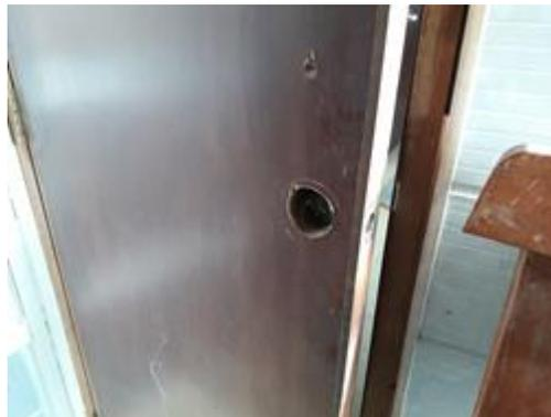
Imagen 66: Evidencia de las puertas deterioradas del Puesto de Control Achica Arriba.
