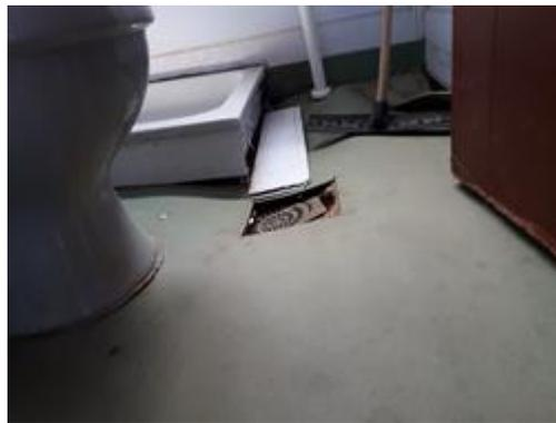
Imagen 69: Evidencia de pisos deteriorados del Puesto de Control Los Troncos.
